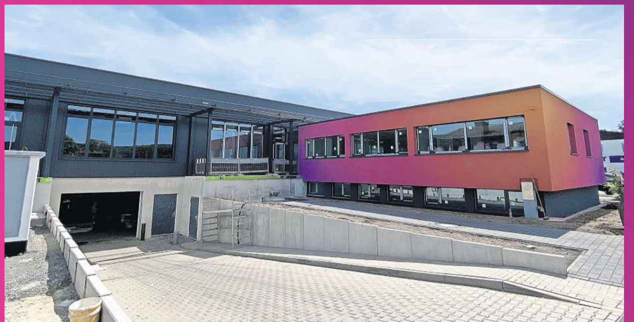
Ansicht von der Zeppelinstraße mit der markanten Fassade in Schwarz und Rottönen.
