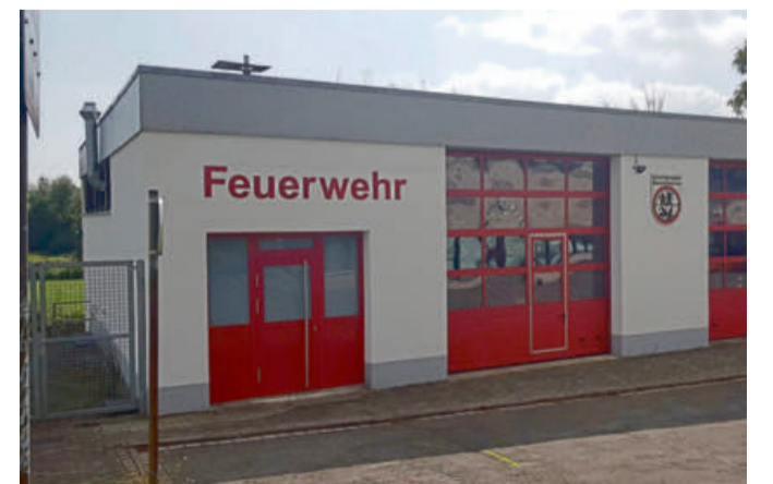
Das Gerätehaus in Neuenheerse wird auch erweitert. 250.000 Euro Landeszuschüsse fließen. Foto: Marius Thöne
